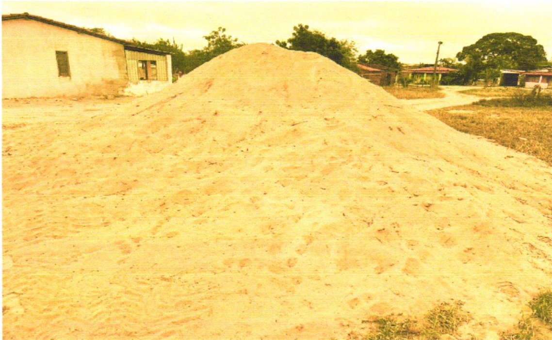
(FOTO 03) AREIA PARA COMPACTAÇÃO DO LEITO
