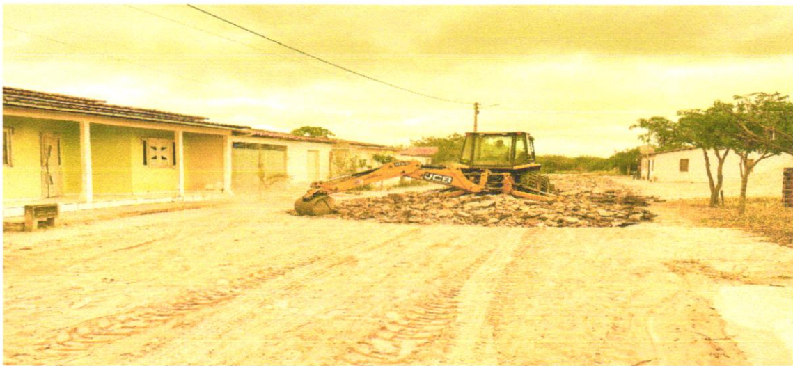
FOTO 01 REGULARIZAÇÃO E COMPACTAÇÃO
