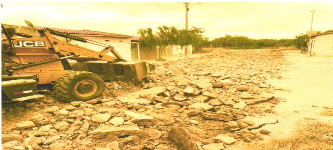
FOTO 02 REGULARIZAÇÃO E COMPACTAÇÃO
