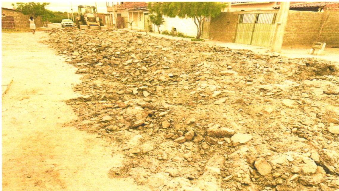
(FOTO 04) REGULARIZAÇÃO E COMPACTAÇÃO
