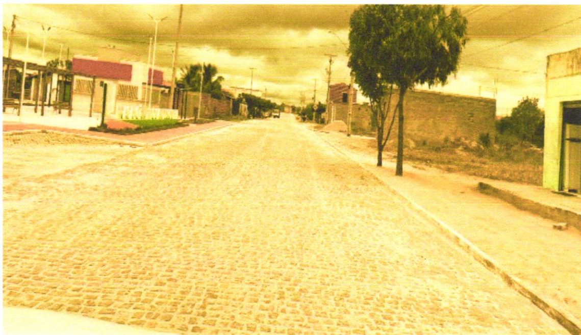
(FOTO 06) EXECUÇÃO DE PAVIMENTAÇÃO E MEIO FIO
